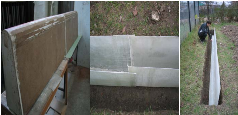
Foto 3. Diferite etape de realizare și montare a rigolelor din PAS.
