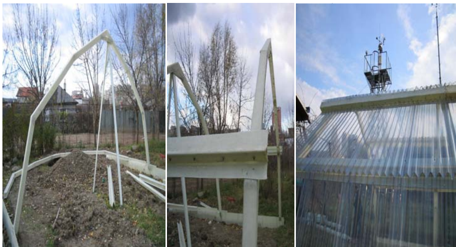
Foto 5. Diverse faze de montaj a serei prototip din PAS și elemente din policarbonat.
