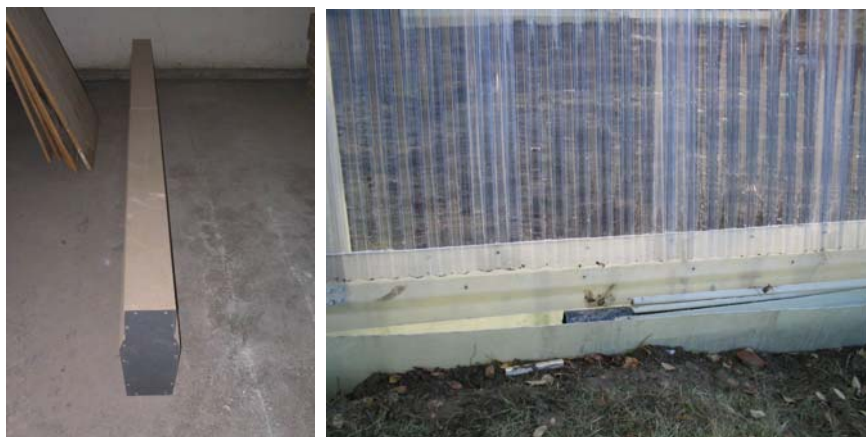
Foto 4. Tipar și detaliu de montaj șorț din PAS.
