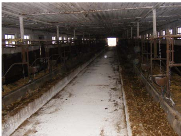
Fig. 3.16. Interior adăpost cu întreținere legată pe două rânduri Indoor housing with maintenance connected on two occasions
