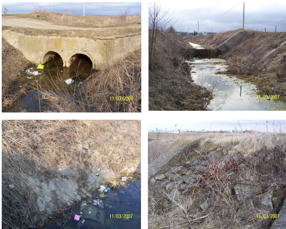
Foto 1 Construcții hidrotehnice din sistemul de desecare-drenaj Bogdănești-Baia
