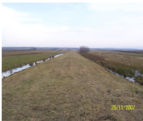
Figura 1 Stagnarea apei și instalarea vegetației higrofile pe rigole
