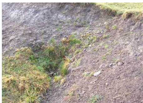
Foto 1. Gura drenului colector DC 7
