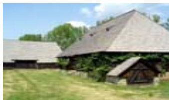
gospodărie cu curte simplă specifică așezărilor răsfirate
