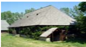
casă cu două camere de locuit, două cămări, pridvor
